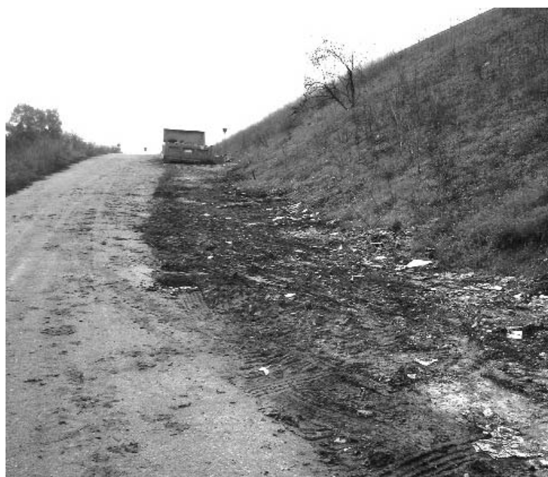
Gli interventi di pulizia sulla complanare della Sp 231, prima e dopo
